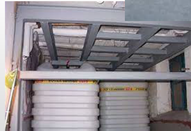
Variante 2 Tankanlage durch Verankerung sichern
